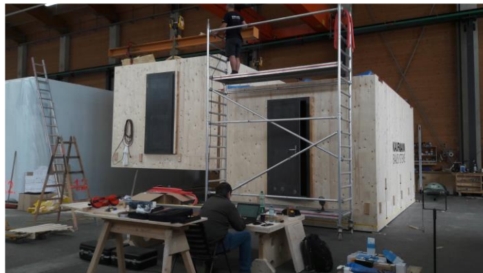
Abbildung 54: Modell-Module in 1:1 zur Untersuchung der Trittschalldämmung von Deckenbauarten in Modulbauweise in Vorbereitung zur Messung
