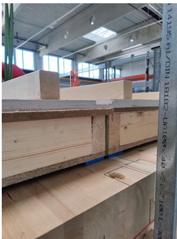
Abbildung 31: Beispielfoto einer Messsituation eines Deckenaufbaus mit dem Fußbodensystem „Punkt“ auf einer Brettstapeldecke
